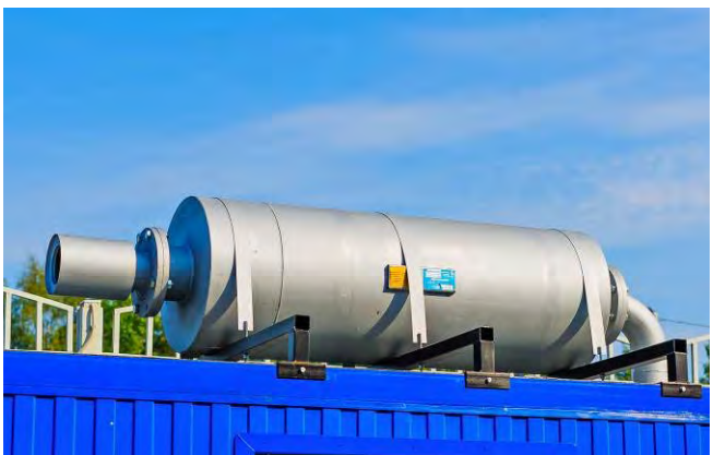
Промышленный глушитель с искрогасителем на крыше контейнера
