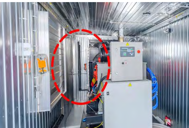
«Дыхательный» клапан для отвода паров топлива из топливного бака за пределы контейнера
